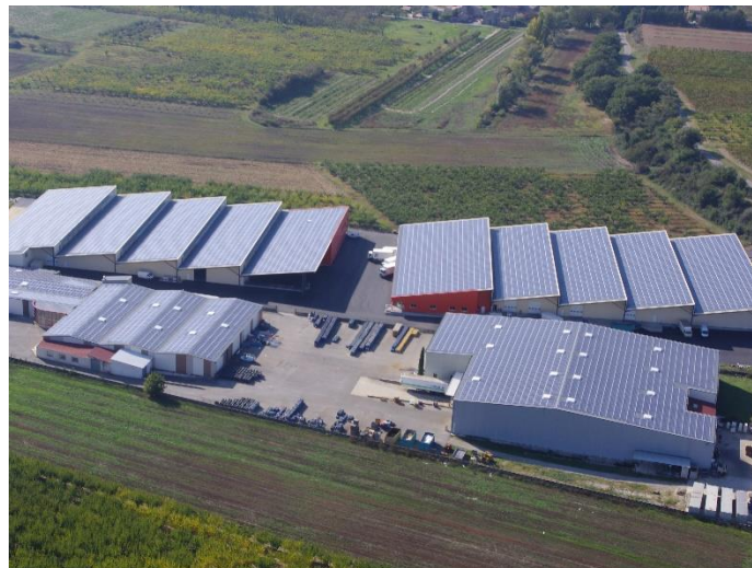
Illustration : centrale de 2 537 kWc à Pont de l'Isère
