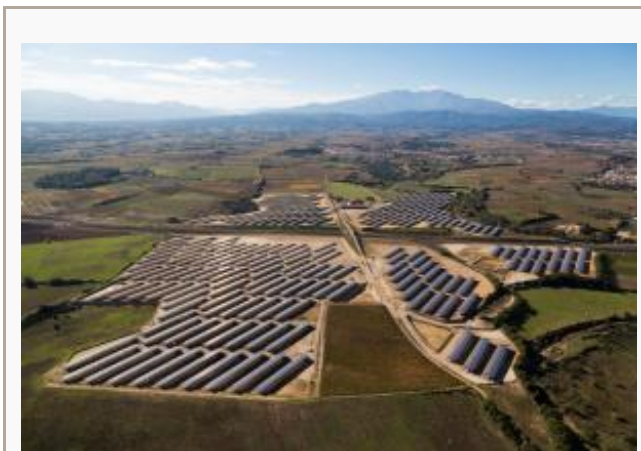
France, Pyrénées-Orientales (66), Trouillas, site de Canterrane, 94 000 m 2 de toiture photovoltaïque sur des serres pour la culture d'asperges, d'une puissance de 11,6 MWc, Cap Vert Energie, producteur indépendant d'énergie renouvelable (vue aérienne)
