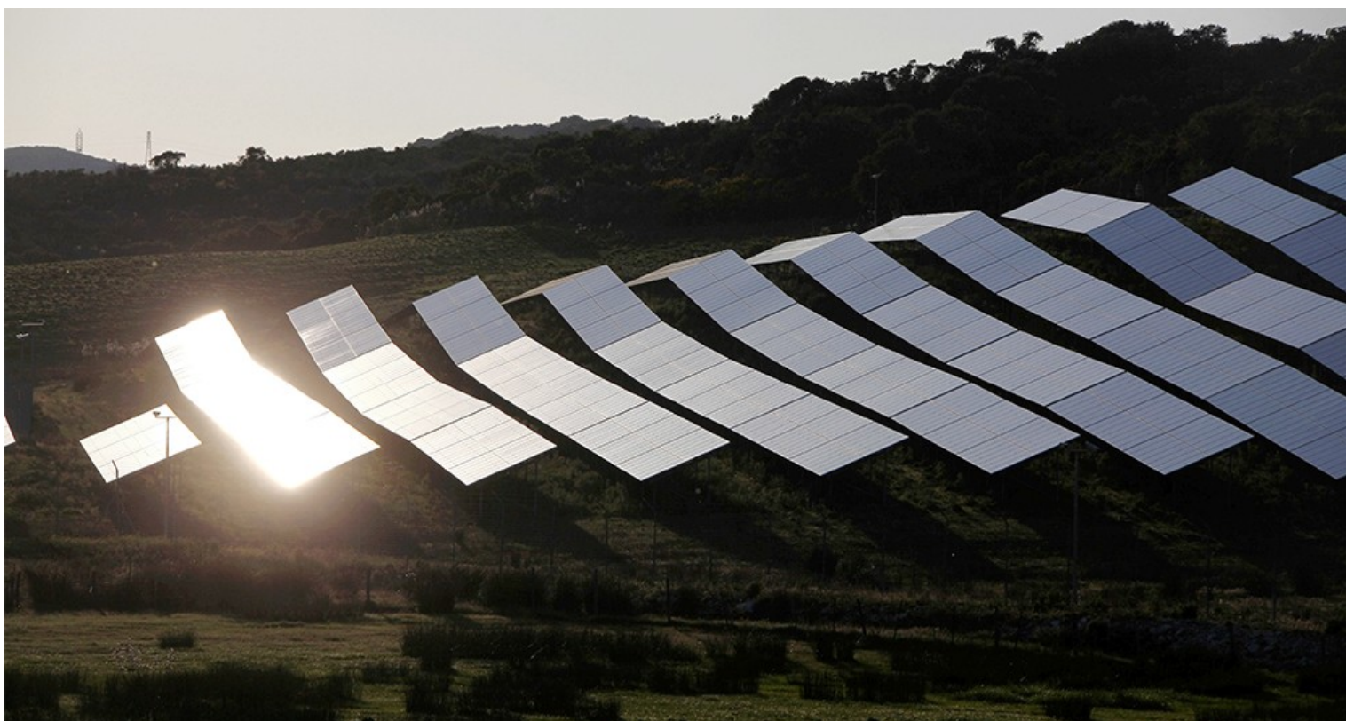
Panneaux photovoltaïques. Ferme solaire sur la RN198 entre Porto Vecchio et Bonifacio. - Laurent Grandguillot/RÉA
